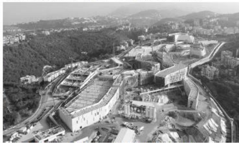
正在黎巴嫩贝鲁特建设中的新美国大使馆大楼鸟瞰图。
